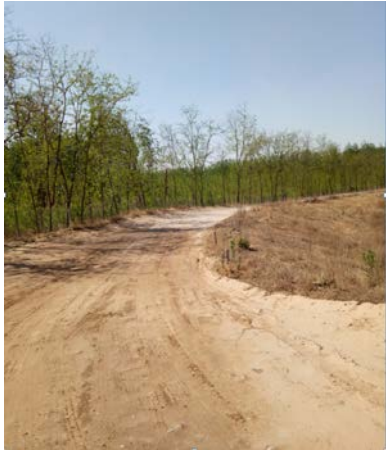
图 9 北小埝（廊坊段）现状
