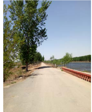
图 11 新龙河右堤现状
